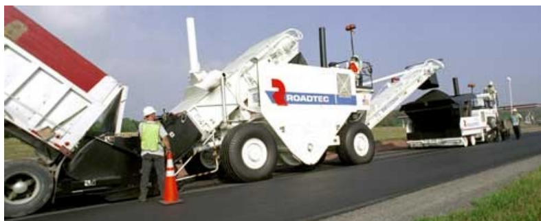
Рис.1. Перегрузка асфальтобетонной смеси в асфальтоукладчик
